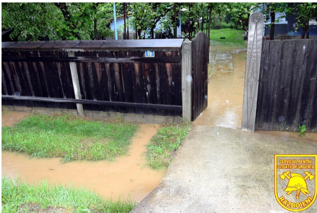
Figură 43: Gospodărie afectată în timpul ploilor torențiale din noaptea de 2 spre 3 iunie, anul 2016 - „singura problemă deosebită fiind semnalată în satul Războienii de Jos pe DJ 208G, km 0,2 unde au fost afectate un număr de 3 gospodării.” (sursa: https://www.facebook.com/comunarazboieni )
